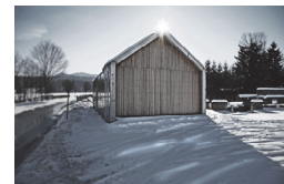
Kleinwasserkraftwerk Fuschler Ache Thalgau 2011
