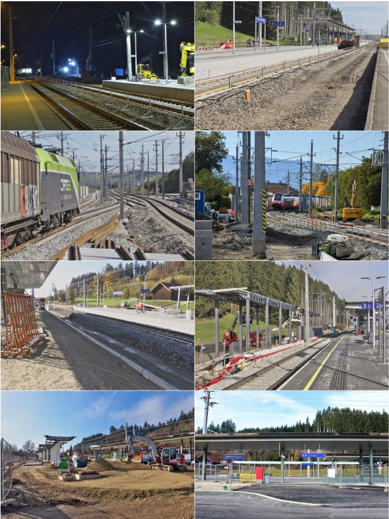
Bilder August bis Dezember 2020. Links oben eine Aufnahme am 25. August 2020 um 23:20 Uhr. Der alte Bahnsteig Fahrtrichtung Salzburg wird gerade abgerissen. Darunter sieht man gut, wie während der Bauzeit immer wieder die Geleise verschwenkt werden mussten, um die neuen Gleise errichten zu können. Auf den nächsten beiden Seiten Bilder nach der Fertigstellung 2021, 2022 und 2023 (vorletztes Bild, die beiden railjets, das letzte Bild zeigt den Platz, wo ehemals die Fahrradständer und Kleingärten standen).
