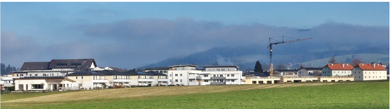
26. November 2020, rechts entsteht die „Kinderstadt Neumarkt“, der neue Kindergarten.
