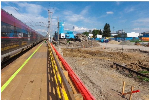
Baustellensituation am (noch) Bahnhof Neumarkt-Köstendorf am 16. September 2019. Rechts der spätere unterirdische Zugang zu den Gleisen 2 und 3. Dieser wurde als ein fertiger Bauteil eingeschoben. Alle Bilder vom Umbau des Bahnhofes von 2019 bis 2022 gibt es auf meiner Bilderplattform unter diesem Link (~ 220 Bilder) .
