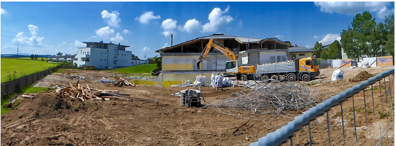
Nach dem Abbruch des Vereinshauses im Juli 2020.
