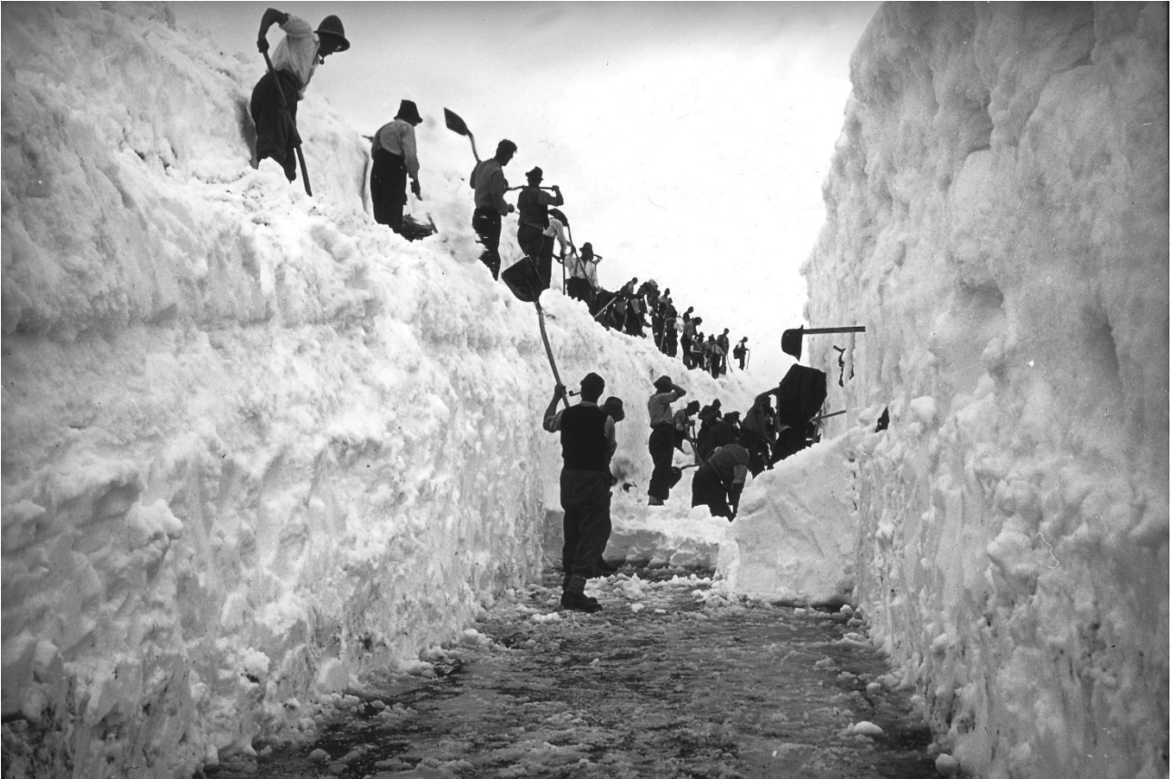
Bild oben: In Schichten wurde der Schnee abgetragen, bis man auf der Straße angelangt war. Bild unten: Schneeschaufler im Abschnitt zwischen dem Mittertörl Tunnel und Hochtörl Tunnel. Bildquelle: Großglockner-Wallack-Archiv
