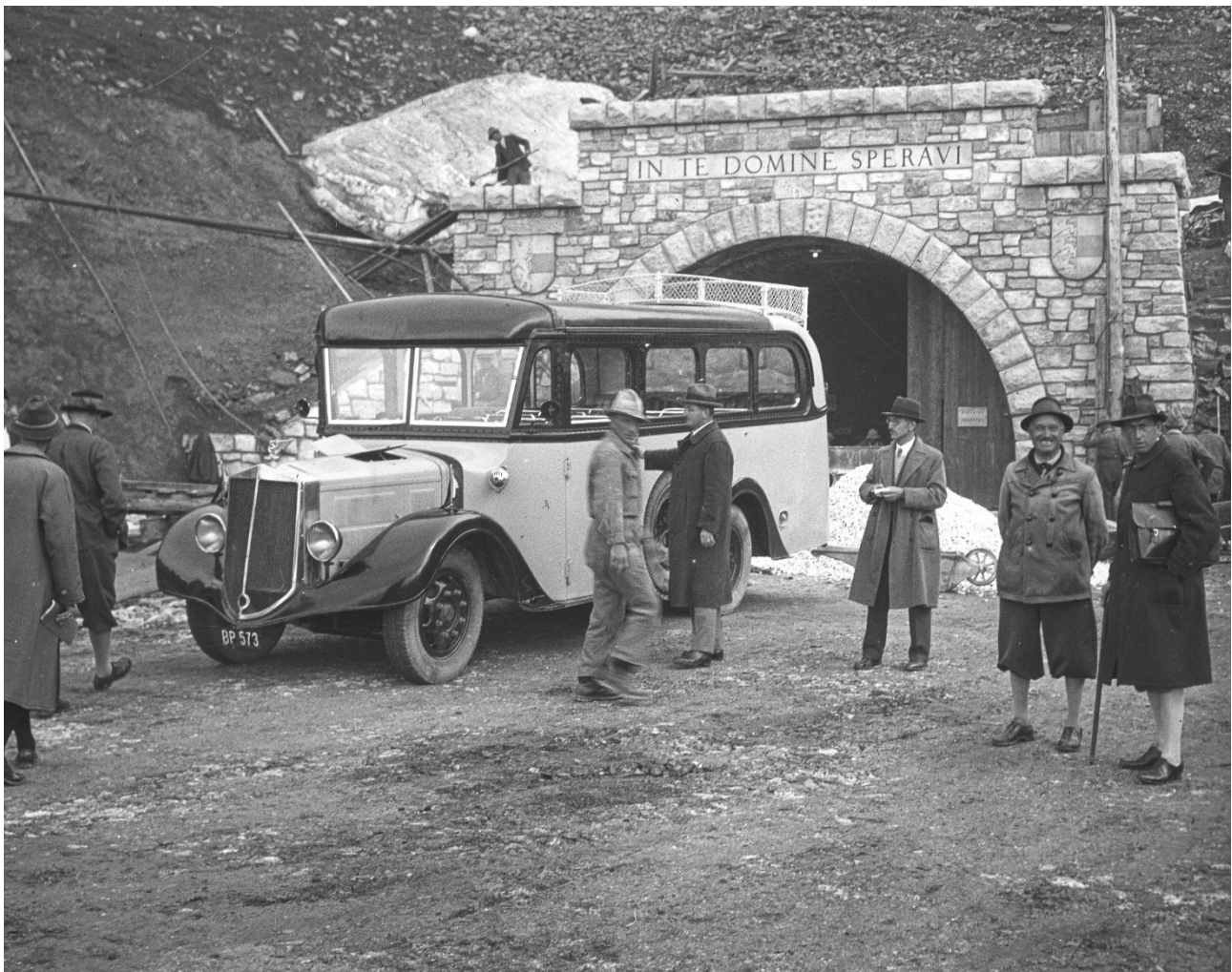
Der erste Postkraftwagen 1935 am Südportal des Hochtör-Tunnels. © Franz Wallack, Großglockner-Wallack-Archiv
