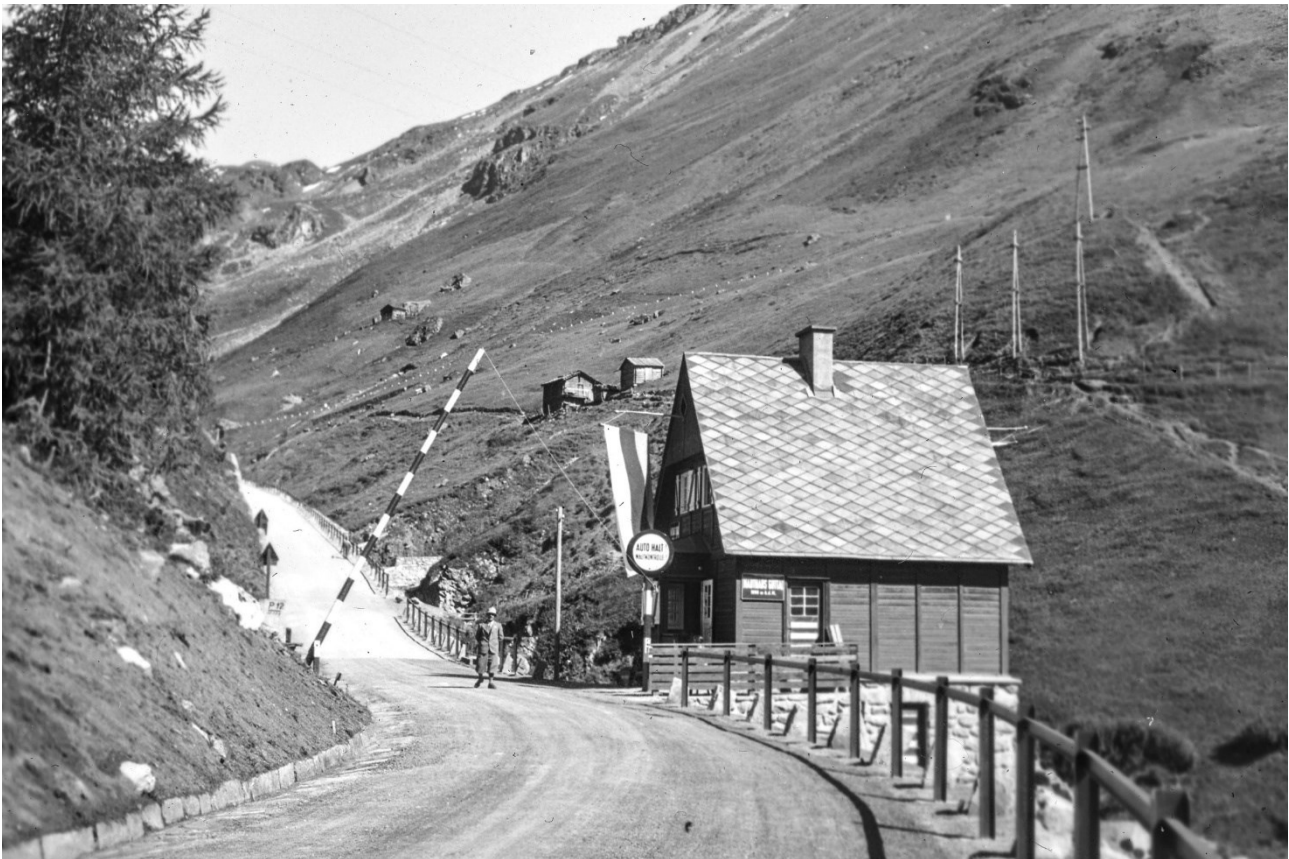
Das Mauthaus Guttal an seinem historischen Standort am Guttalbach an der Scheitelstrecke. Bildquelle Großglockner-Wallack-Archiv.
