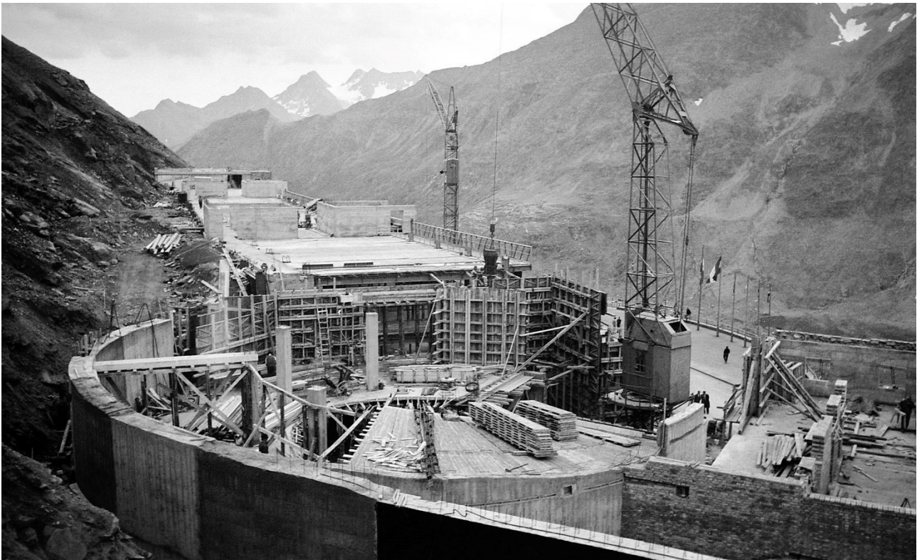
Hier entsteht der Ausfahrtsturm im Sommer 1961. © Dr. Helmut Krackowizer, Archiv Krackowizer
