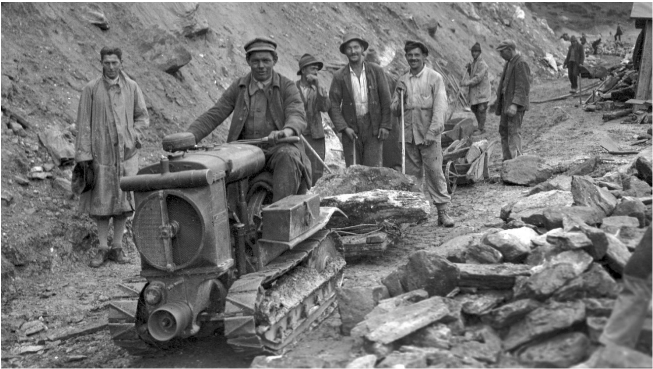
Arbeiterpartie beim Bau der Großglockner Hochalpenstraße. Bildquelle Großglockner-Wallack-Archiv.
