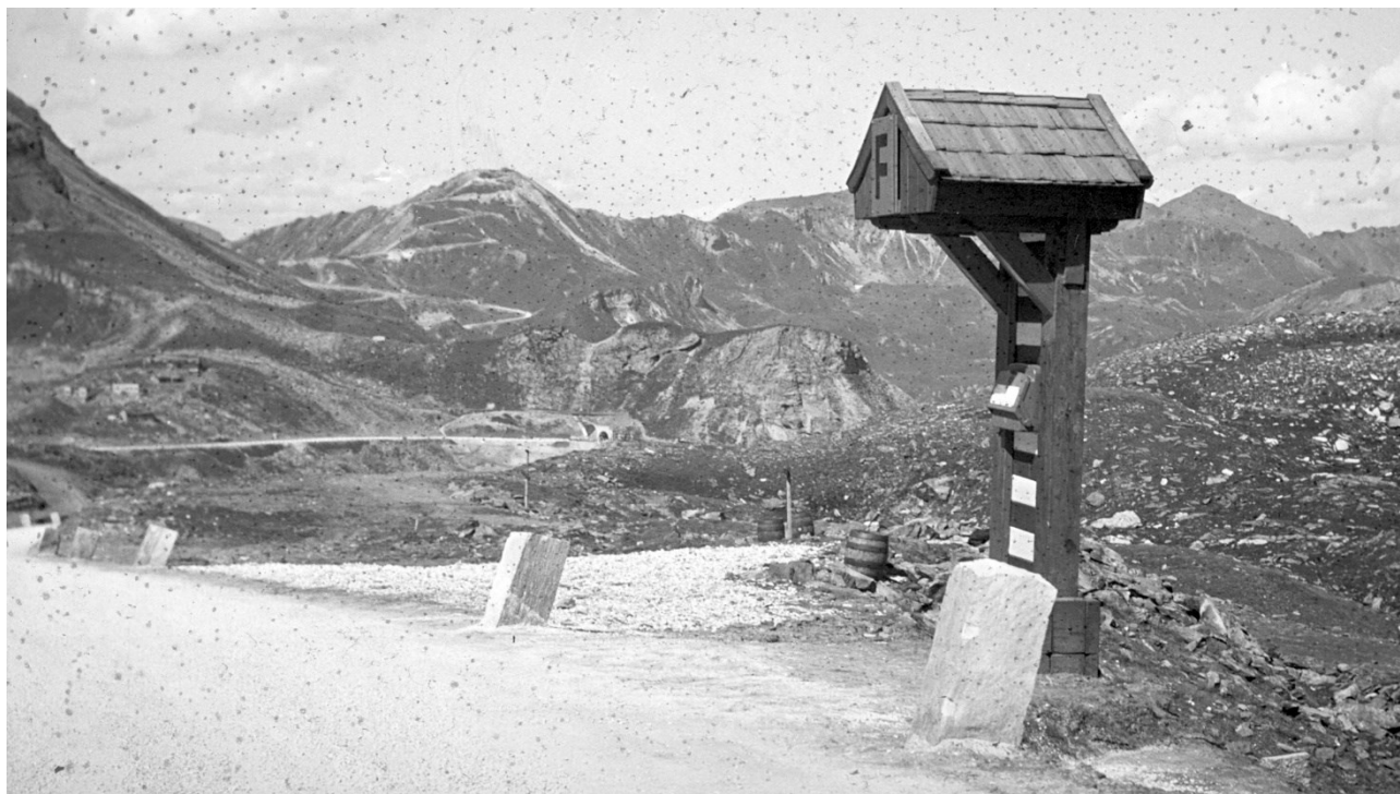
Der Straßenfernsprecher bei Kilometer 32,0 bei der Fuscher Wegscheide. Bildmitte das Südportal des Mittertörl Tunnels, leicht links dahinter die Edelweißstraße mit der Edelweißspitze. Bildquelle der beiden Schwarzweißbilder in diesem Artikel Großglockner-Wallack-Archiv.
