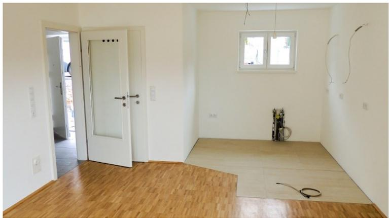
Das Kabel rechts am Boden zeigt die „schwierige Lage“ des Bohrlochs für den Anschluss des Elektroherds.
